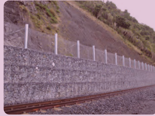
پایداری سازی شیب به روش دیوار حائل گابیونی (تور سنگی)
