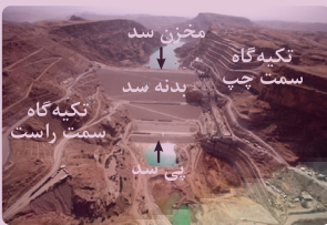
نمایی از بخش‌های مختلف یک سد
