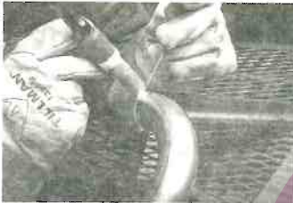
اتصال یا جوش کاری
